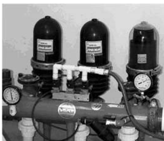
شکل (۶) - نمای کلی از فیلترهای دیسکی و نحوه نصب آنها در سیستم تصفیه آب
